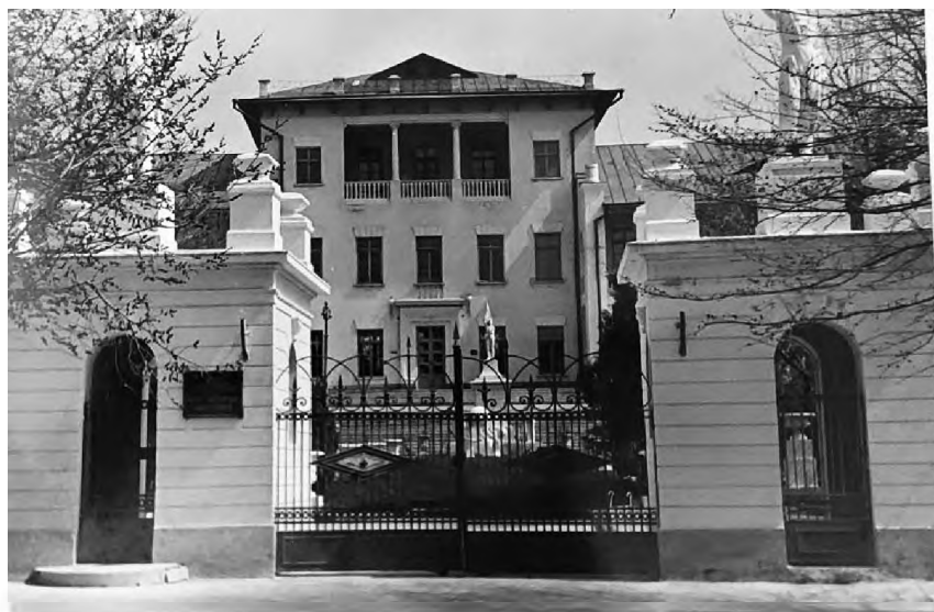
Здание главного лечебного корпуса функционирует по настоящее время
