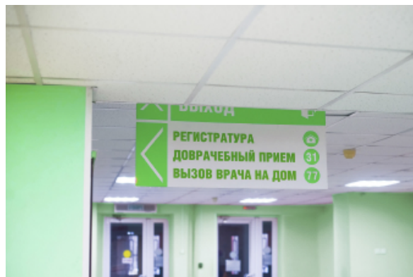
Рис. 1. Перекрытие части подвесного навигационного знака гипсокартонным потолком, Вологодская область
