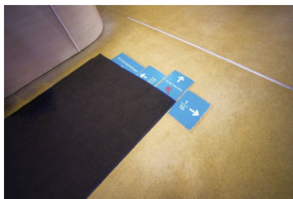
Рис. 2. Перекрытие части напольной навигационной наклейки ворсовым грязезащитным покрытием, Калининградская область
