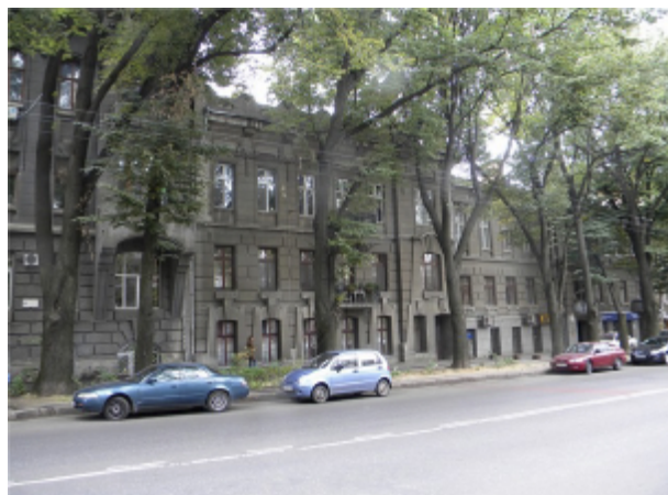
Рис 4. Доходный дом Ю. Ломейра. Построен в 1911 году по проекту архитектора В.И. Прохаска. Памятник истории и архитектуры, в котором проживал Щастный С.М. с семьей в 20-е годы (в пятикомнатной квартире).
